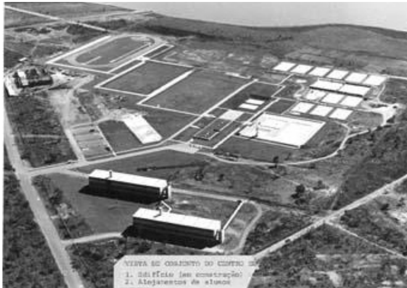
Fotografia 2 – Vista Aérea da Construção do Centro Olímpico. Janeiro de 1971
